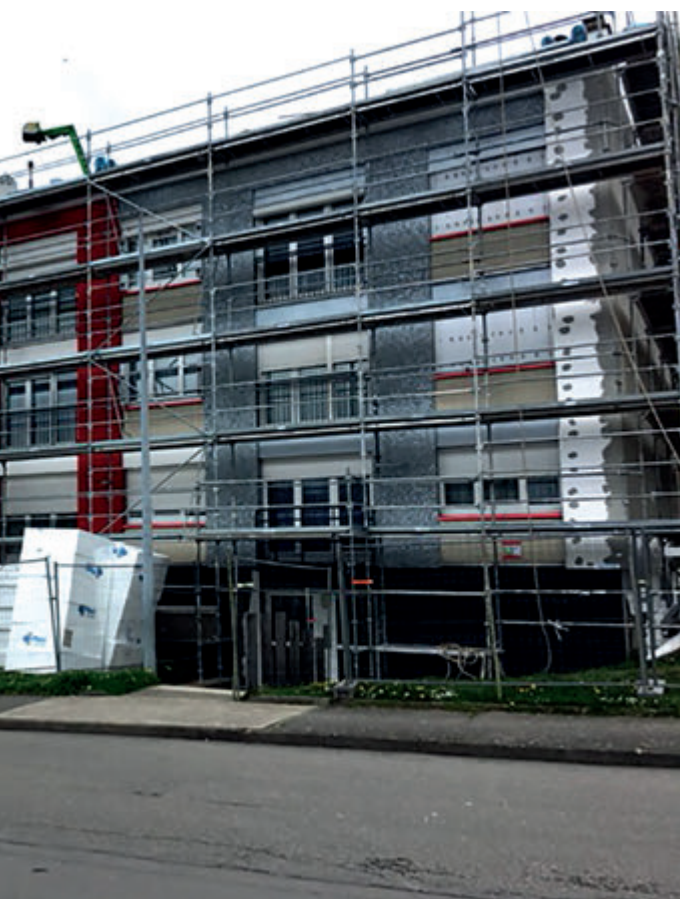
Travaux VAF - Châteaubriant
