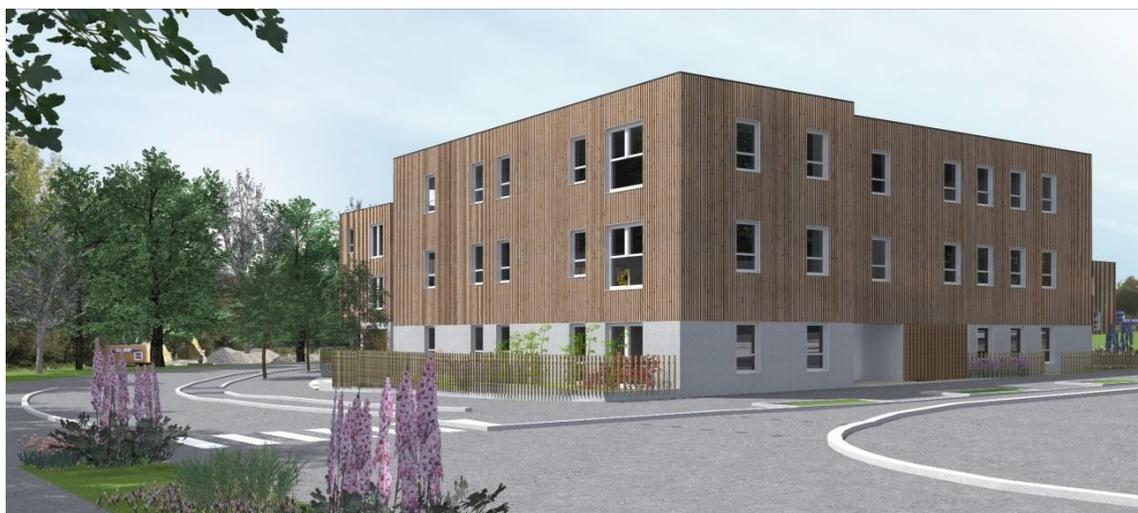
Les bâtiments collectifs sont constitués d'un **noyau en maçonnerie de béton** (parking souterrain et partie centrale regroupant les cages d'escalier et d'ascenseur ainsi que les garages à vélos), autour duquel viennent s'assembler **les modules à ossature bois** composant les logements.
