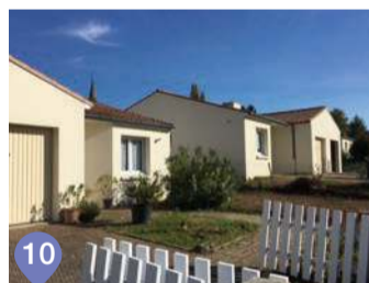
10 Le Landreau, rénovation énergétique
