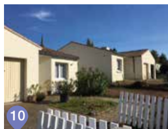
10 Le Landreau, rénovation énergétique
